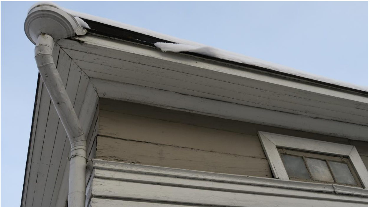
Kuva 98. Umpeen laudoitettu räystäälunnen on viimeistelty simssilistan tapaan. Vinttikerroksessa on haukkaikkunat.
