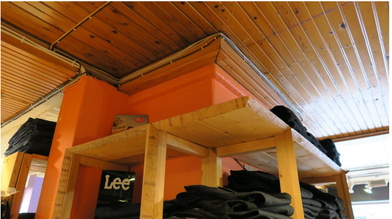
Kuva 138. Liiketilan keskiosasta; näkyvissä vanhaa muurirakennetta 1900-luvun alkupuolelta. Kattopanelointi on 1950-60-luvulta.
