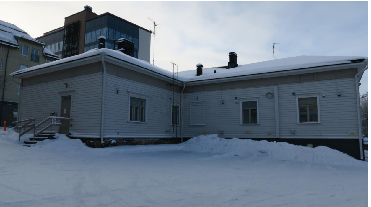
Kuva 92. Raittiustoimiston pihajulkisivu koillisesta. Kuvassa taustalla näkyy Kirkko- ja Kuninkaankadun korkeampaa rakentamista ja uudisrakennus.
