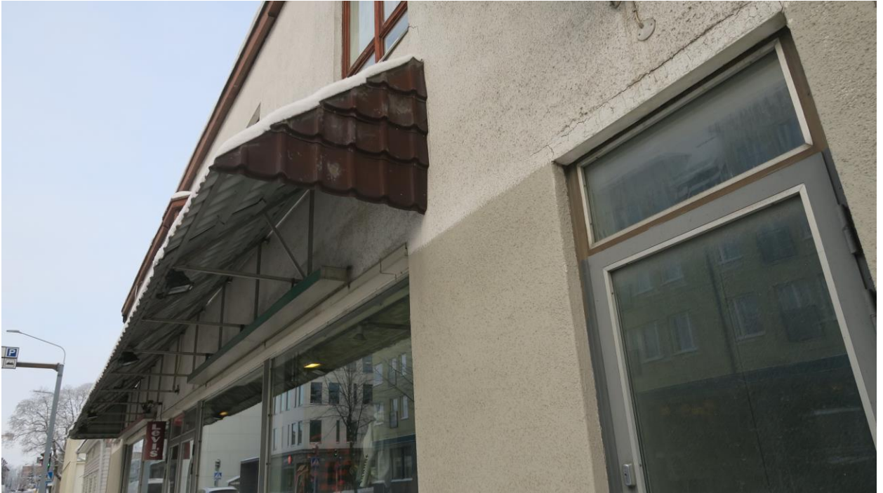
Kuva 133. Pääjulkisivulta Koulukadulta, sisäänkäynnin lippa profiilipelistä ja ulko-ovi itäpäädyssä toisen kerroksen asuinhuoneistoon.
