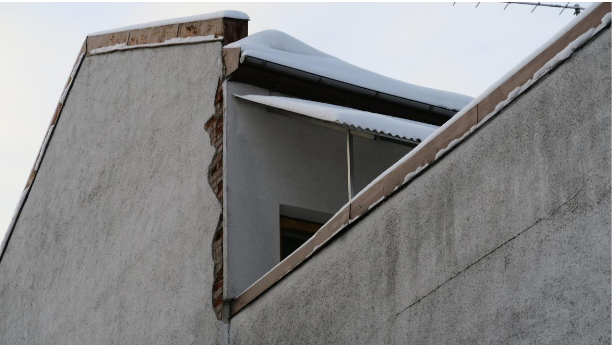
Kuva 132. Toisen kerroksen sisäpihan parvekkeesta ja korotetun osan tiilirungosta.
