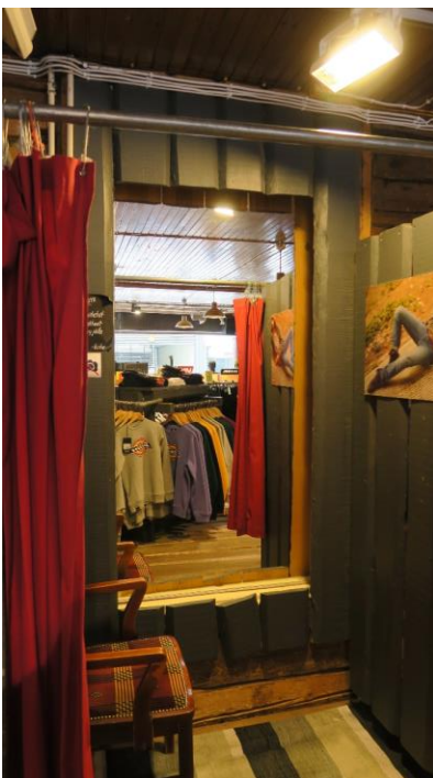
Kuvat 142, 143, 144. Vasemmalta oikealle vanhan runko-osan säilyneet ikkuna-aukot havaittavissa pukukopissa ja etelän hirsiseinässä.
