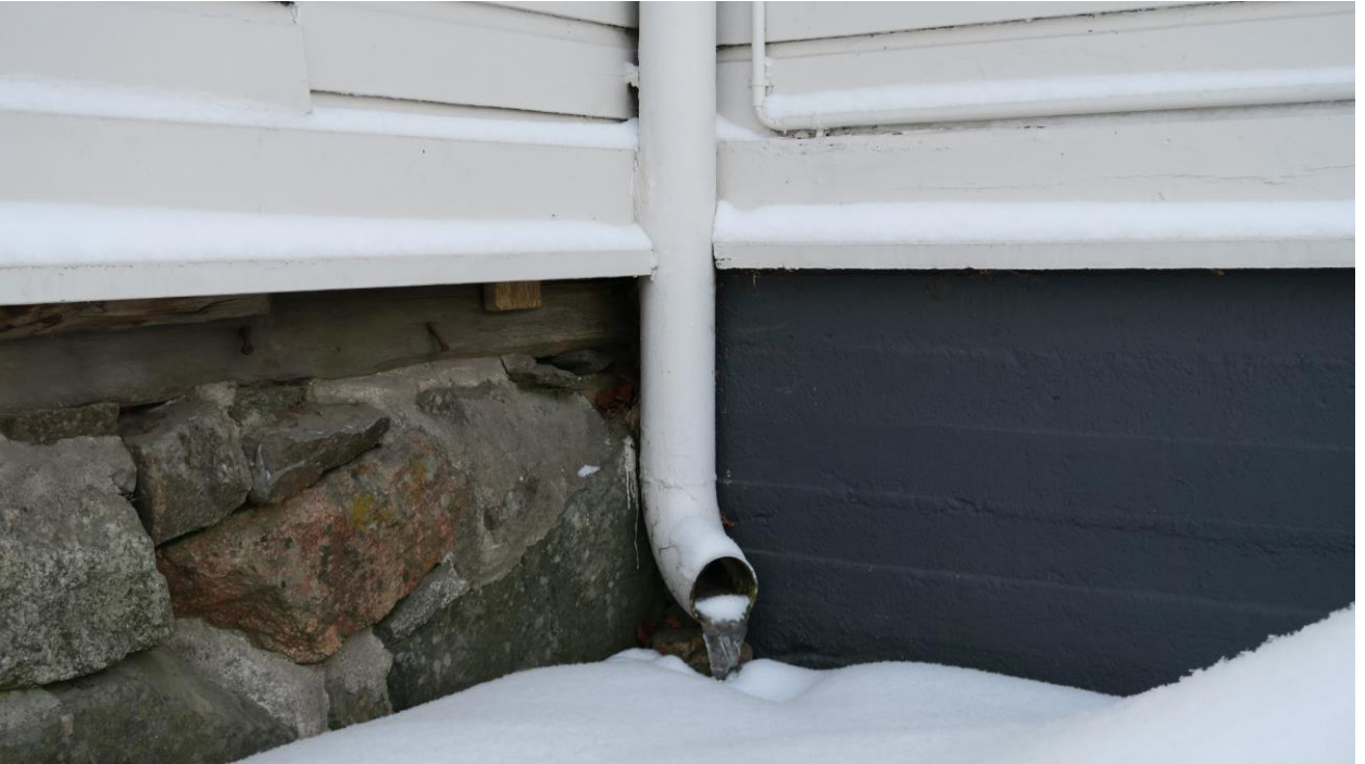
Kuva 99. Sisäpihalta vanhimman rakennuksen ja laajennusosan yhtymäkohta. Luonnonkivi ja betonia kivijalassa.
