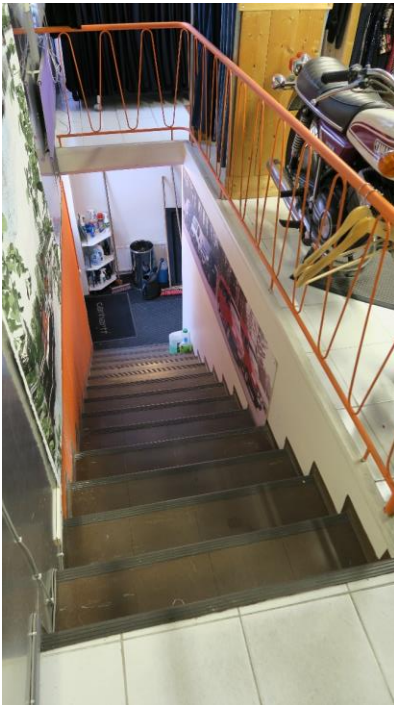
Kuvat 148, 149, 150. Vasemmalta oikealle raput ja teräspinnakaide 1950-luvulta alakertaan kellaritiloihin. Ovi kellariin ja toimistotiloihin. Kellarin wc-tila.
