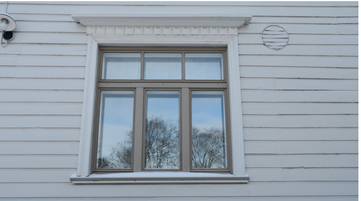
Kuva 100. Sisäpihan uusittu ikkunapuite vanhan 1900-luvun alkupuolen mallin mukaan.
