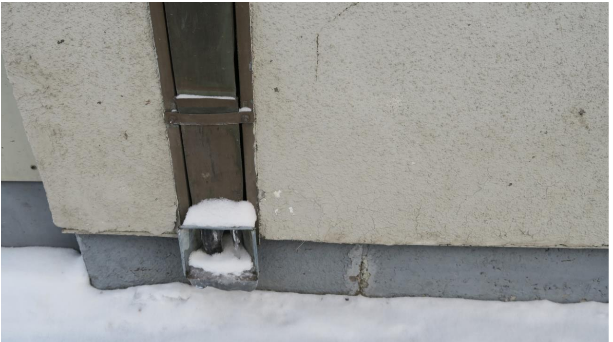
Kuva 134. Kivijalasta ja muotoiltu syöksytorvi 1930-luvun tapaan sisäänvetona julkisivussa.
