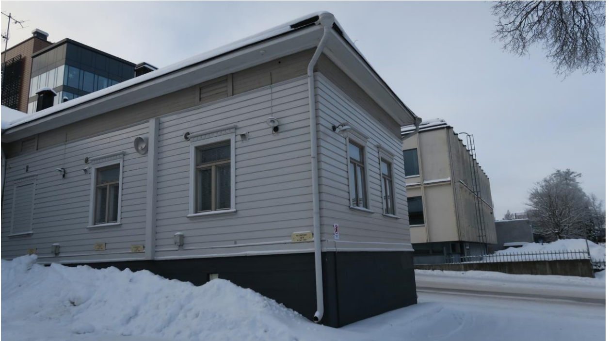
Kuva 95. Talon pohjoispääty ja laajennusosa 1920-luvulta. Korkea betonikivijalka.
