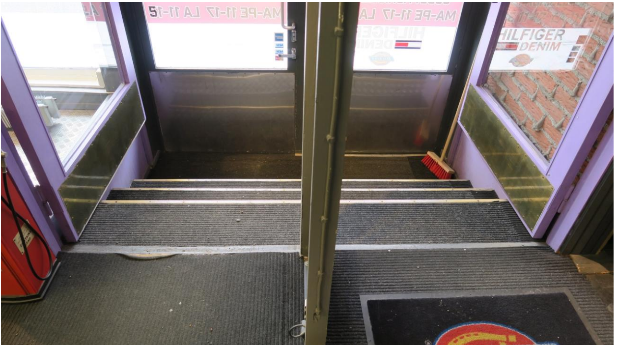
Kuva 136. Sisäänkäynnistä, tuulikaappi ja rappuaskelmat ylös.
