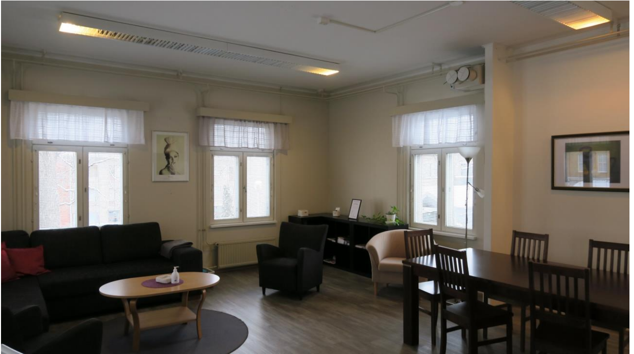
Kuva 105. Laajennusosan salin ikkunoihin länsisivulla ja pohjoispäässä.
