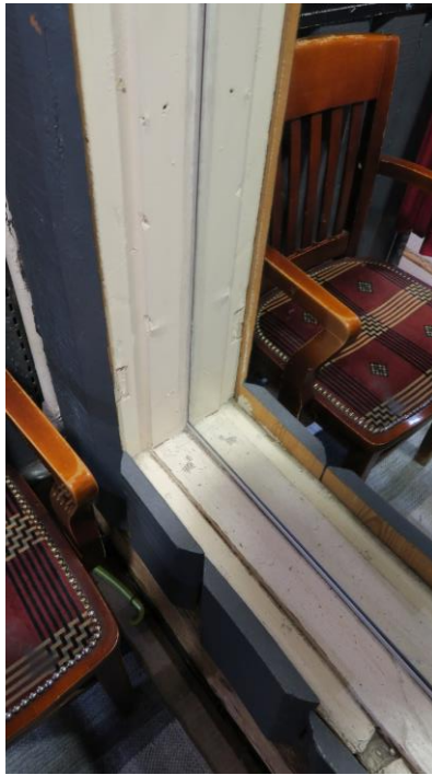
Kuvat 142, 143, 144. Vasemmalta oikealle vanhan runko-osan säilyneet ikkuna-aukot havaittavissa pukukopissa ja etelän hirsiseinässä.
