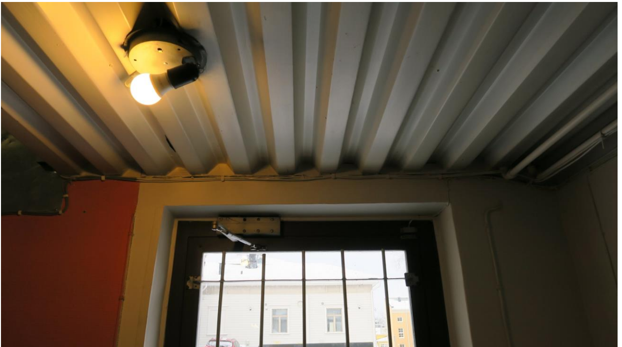
Kuvassa 158. Kellarin laajennusosan länsisivun ovi sisäpihalle.
